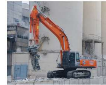
Гусеничный экскаватор HITACHI ZX330 LC-3G
