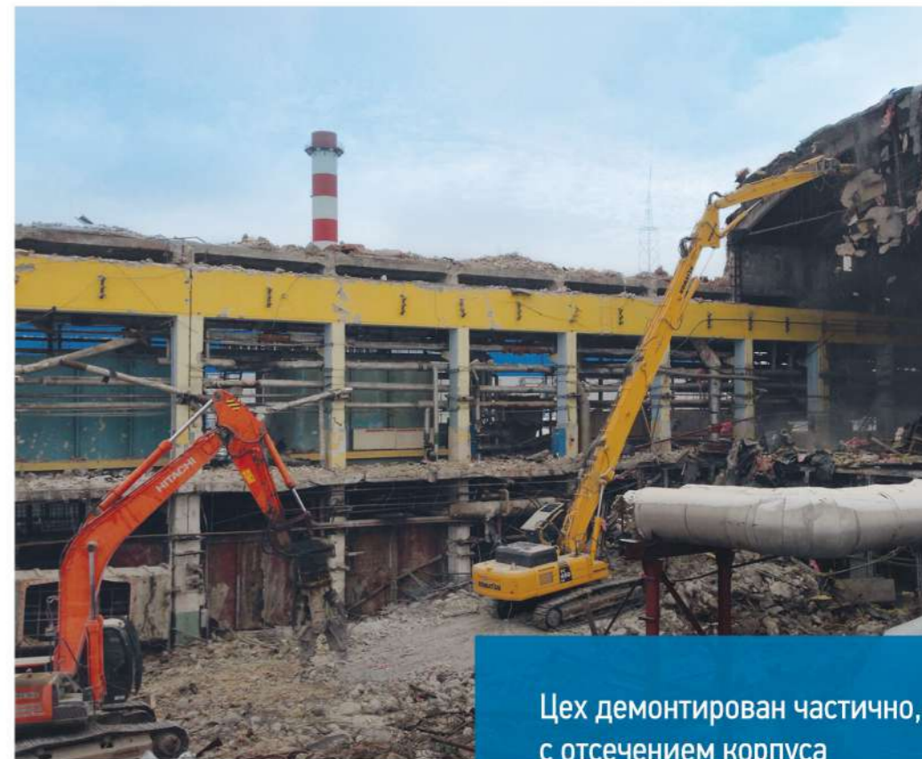
Демонтаж турбинного цеха на Казанской ТЭЦ-2
