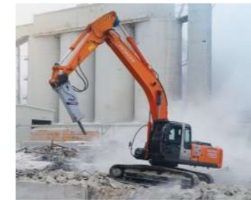
Гусеничный экскаватор HITACHI ZX330 LC-5G
