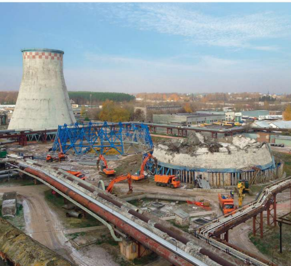
Демонтаж градирен на Казанской ТЭЦ-2 и Ивановской ТЭЦ-3
