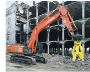
Гусеничный экскаватор HITACHI ZX330 LC-5G
