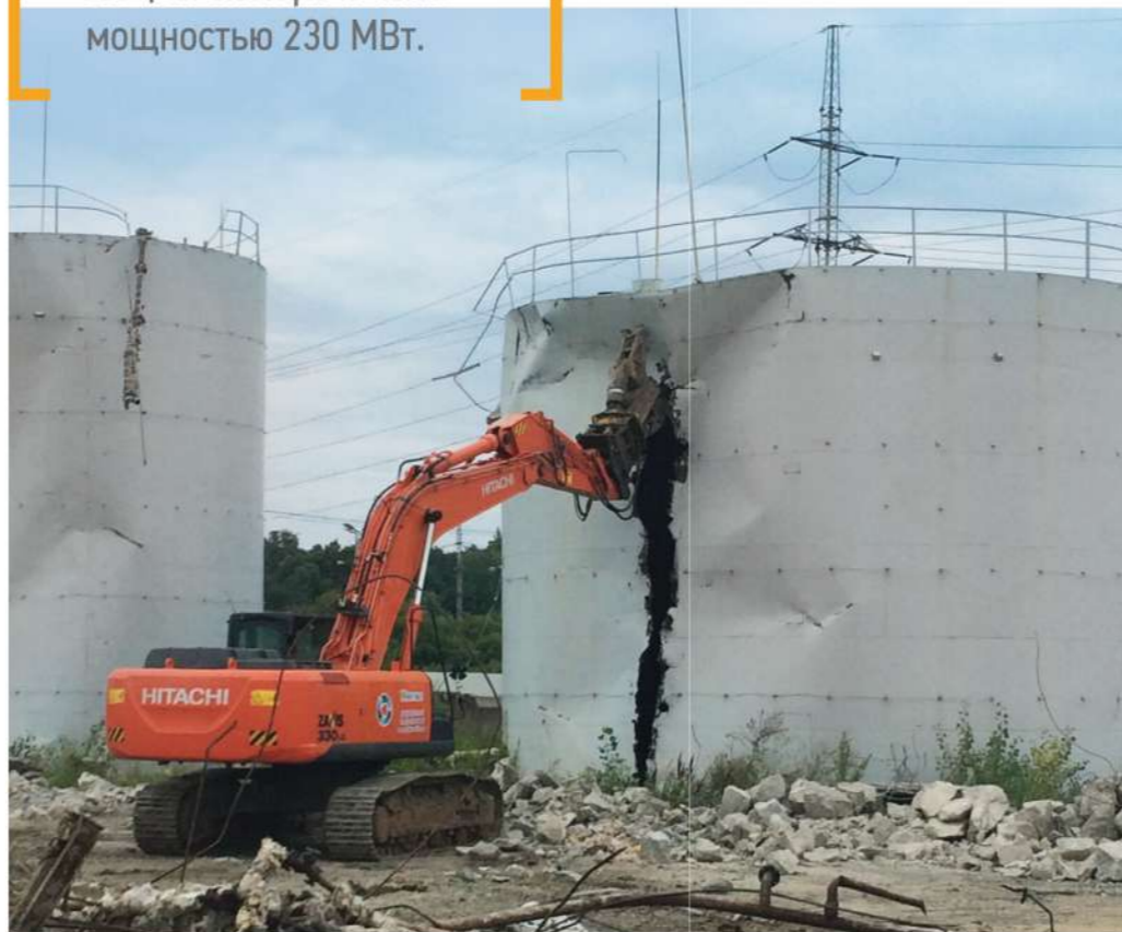
Демонтаж более 70 объектов на Казанской ТЭЦ-1
