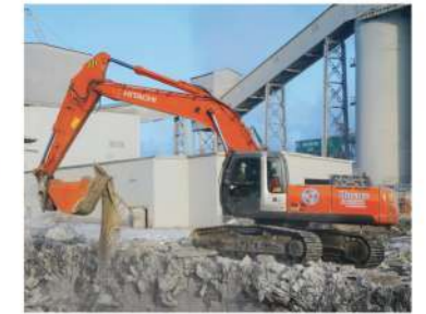
Гусеничный экскаватор HITACHI ZX330 LC-5G
